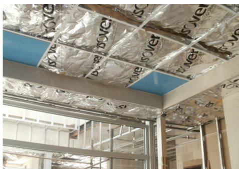
Rolac Plata Cubierta sobre cielorraso desmontable.
