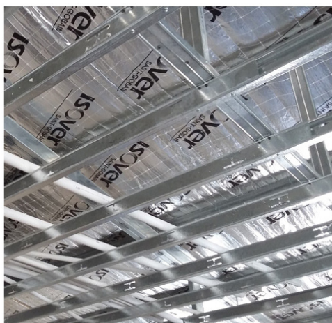
Cielorraso suspendido debajo de cubierta de chapa de pequeñas luces aislada con Rolac Plata Cubierta.
