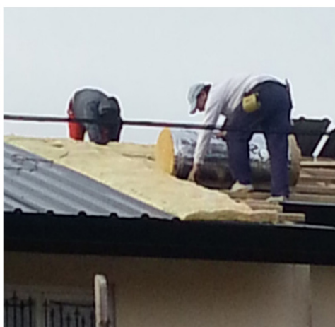
Las chapas se colocan a medida que se avanza con la colocación de la lana para evitar que quede expuesta.
