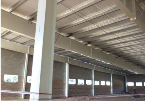
Utilización del Filtro Tensado en cubiertas nuevas.
