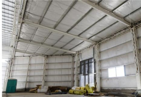
Utilización del Filtro Tensado Polipropileno Blanco en cubierta y cerramiento vertical.
