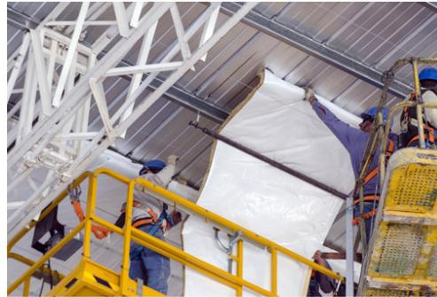
2. Con la ayuda de un rodillo en uno de los extremos del rollo, comenzar colocando el FielTRO Tensado Polipropileno con el foil hacia abajo, haciéndolo pasar por encima de los alambres y tensándolo a medida que se va avanzando. Tomar la precaución de ubicar la solapa longitudinal que posee el rollo siempre hacia el mismo lado.
