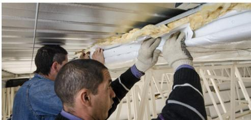
3. Cuando el largo del rollo sea inferior a la distancia a cubrir, el empalme con el segundo rollo se hará mediante una cinta autoadhesiva de polipropileno. Reforzar la unión con un fleje tomándolo a la correa.
