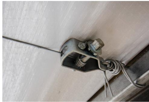
1. Colocar alambres galvanizados (tipo San Martín) tensados entre los perfiles estructurales cada 1 m sujetándolos con una torniqueta.
