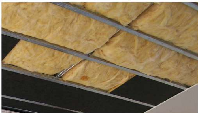
Aislamiento por el interior sobre cielorraso.
