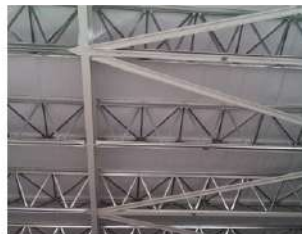
3. Treccionar la malla y la lana en forma conjunta, permitiendo que la lana recupere su espesor entre correas.
