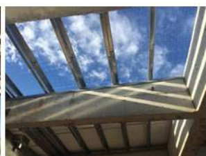
5. Colocar las chapas a medida que se avanza con la instalación para no dejar la lana de vidrio expuesta.
