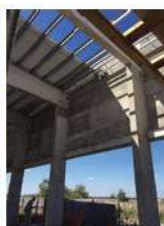
5. Colocar las chapas a medida que se avanza con la instalación para no dejar la lana de vidrio expuesta.
